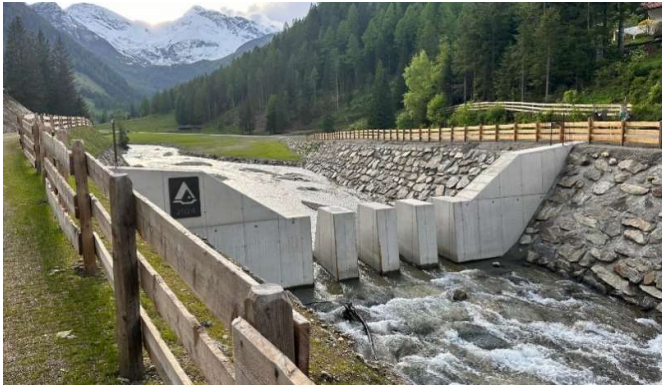
Die Geschiebe- und Wildholzrückhaltesperre im Tauerntal schützt den Ort vor Verkläuerungen und Überschwemmungen
